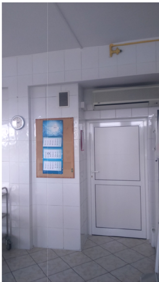
Dok. fot. nr 1/208 –Miejsce na wiatrołap
