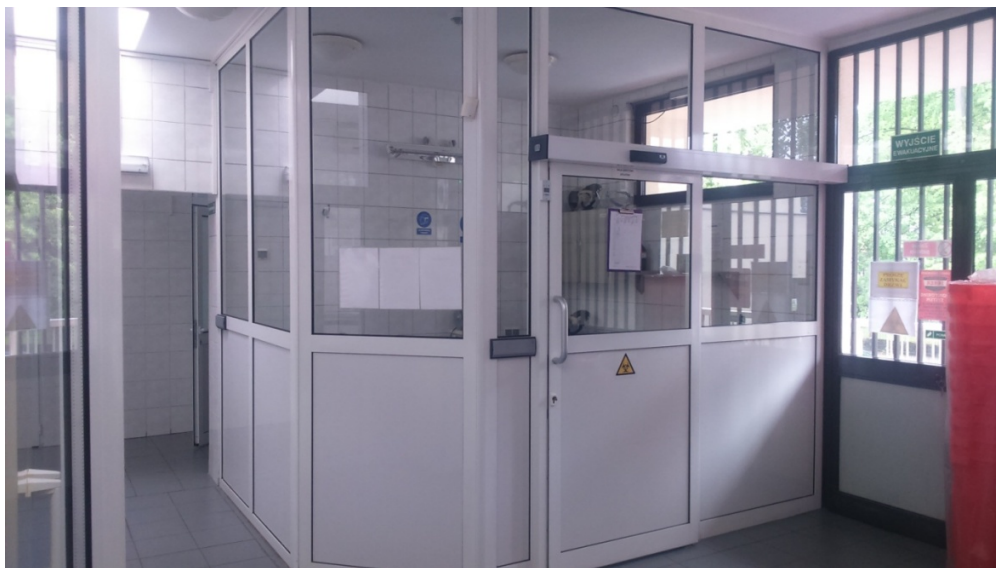
Dok. fot. nr 4/P – Istniejący boks, w którym ma być wykonana od wewnątrz obudowa lekkiej konstrukcji do wysokości max. 111cm od wewnątrz
