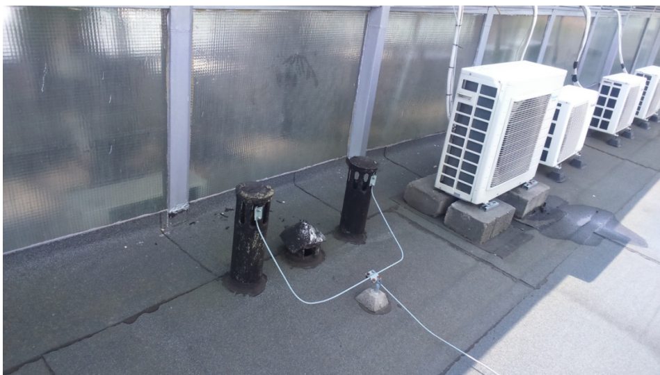
Dok. fot. nr 2/D Dach
