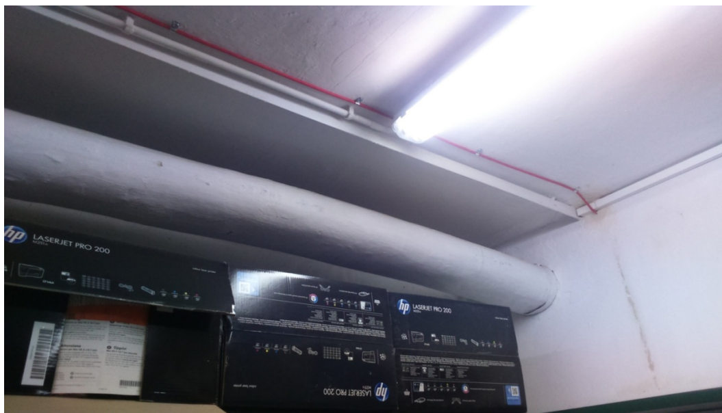
Dok. fot. nr 1/I – Istniejąca otulina z klejem gipsowym
