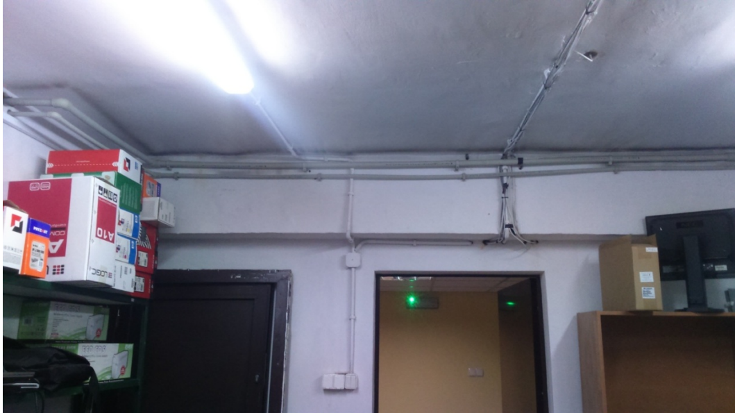
Dok. fot. nr 3/l. Ściana z korytarzem, do zabudowania obudową z płyty G/K
