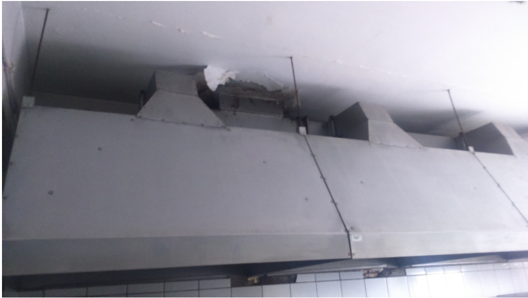
Dok. fot. nr 1/S – Istniejący okap nad stanowiskiem pieców (strona wschodnia) do remontu.
