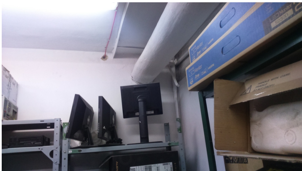
Dok. fot. nr 2/I. – Istniejąca bednarka w narożniku.
