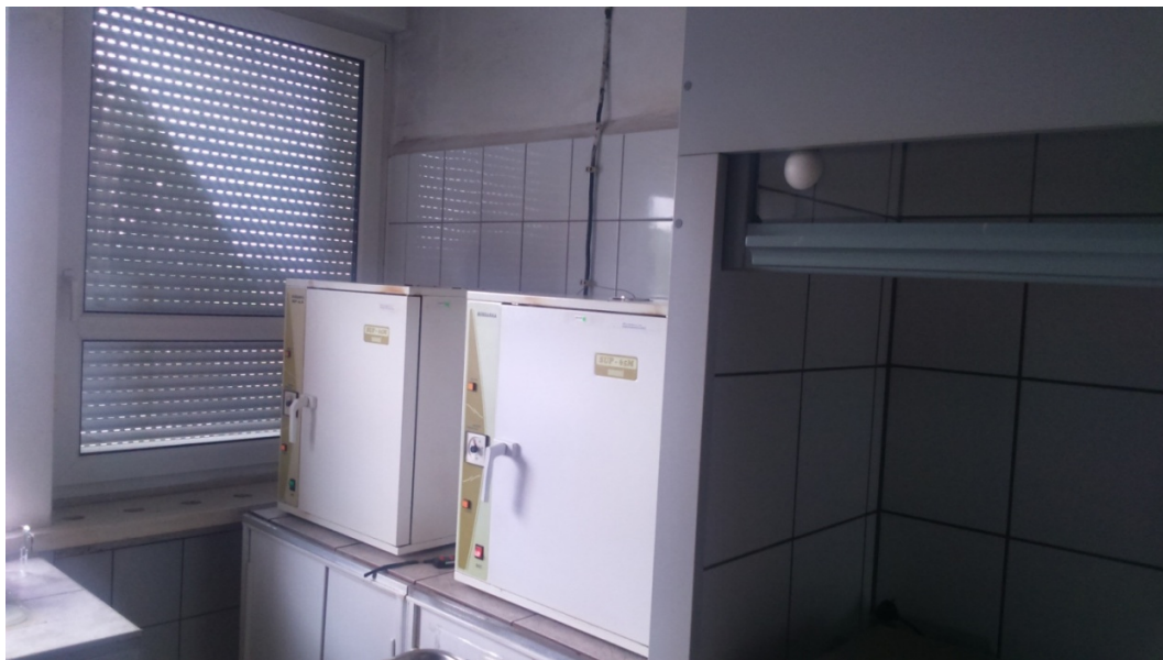
Dok. fot. nr 3/S – Płytki ścienne do usunięcia. Instalacje elektryczne do schowania pod tynk.
